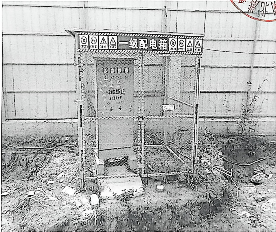
现场照片反映情况文字说明：施工用电接通
