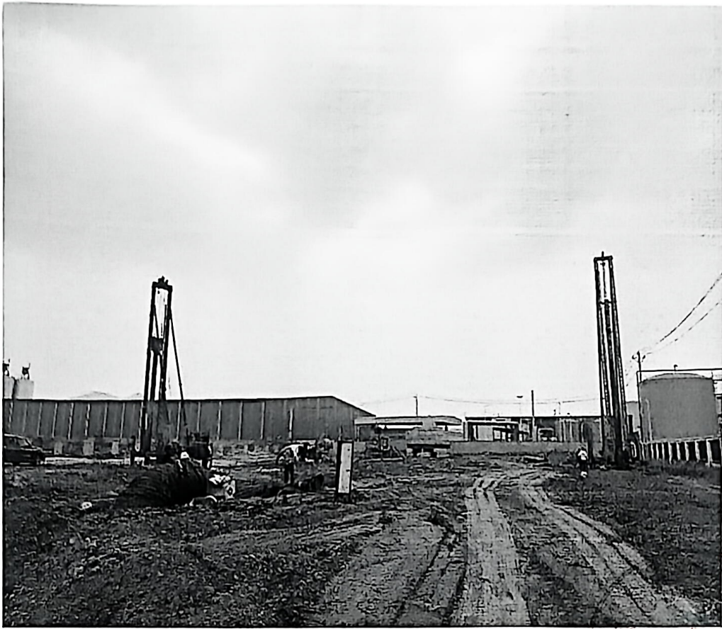
现场照片反映情况文字说明：场地平整、无毗邻建筑、高空无高压线等障碍物
