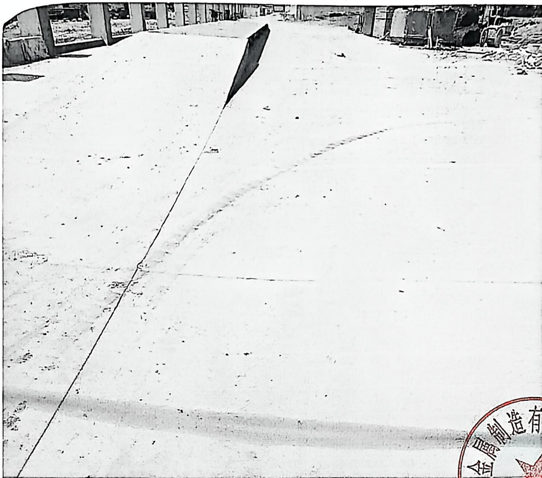
现场照片反映情况文字说明：施工道硬化
