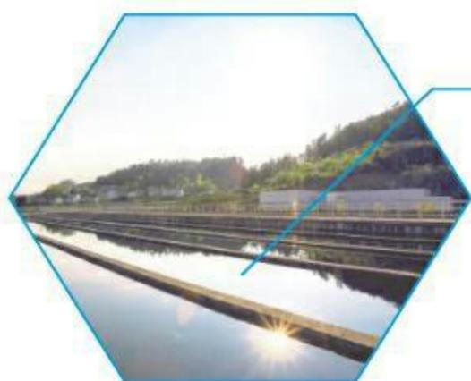
**排水（污）：**规划建设污水处理厂两座，其中1号河口污水处理厂污水处理设计规模为6万吨/日，已建成投产；2号三洲污水处理厂一期、二期工程处理规模3万吨/日已建成投产。
