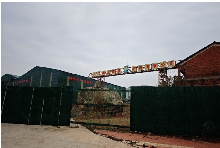
图 3-3：拟拆迁的已停止经营厂房（海口湖大道东延）
